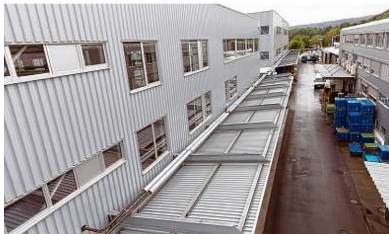
Ohne Leitungen geht es nicht. Im Bild Verbindungsleitungen an den Werksgebäuden der Hago Feinwerktechnik.
