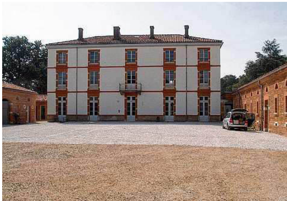
Nach sieben Monaten ist alles unter Dach und Fach: Die Optik des Hauses ist wieder hergestellt und das Innere des großen Komplexes hat ein effektives Heiz- und Klimasystem, made in Germany.
