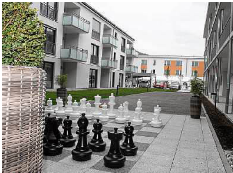
Zahlreiche Gebäude wurden an die Heizzentrale der Stadtwerke angeschlossen, die im Keller des Bahnhofs installiert wurde, darunter das neue Seniorenzentrum.
