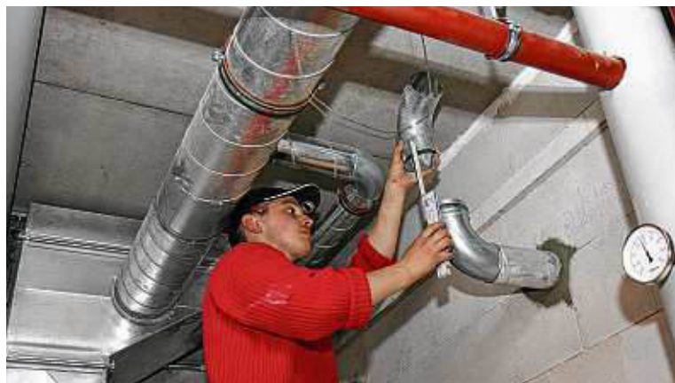
Obermonteur Vitali Frank beim Lüftungsbau. Das Team von Tröndle Haustechnik hat viel Erfahrung in Planung und Installation effizienter Be- und Entlüftungsanlagen mit Schwimmbadtechnik.
