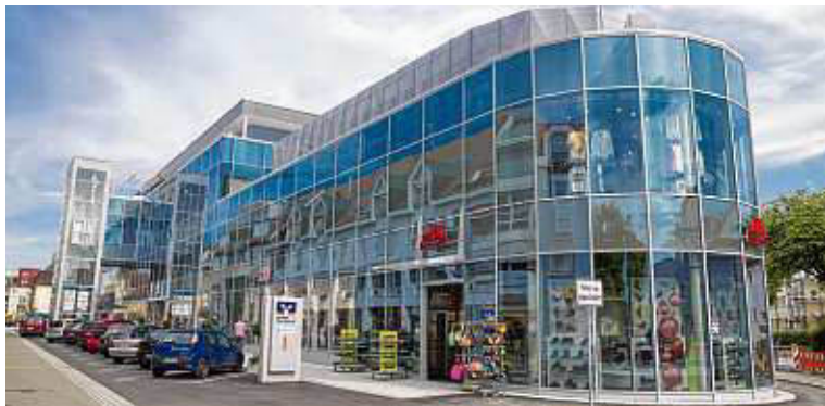
Es ist geschafft: Das fertige und nach modernsten Gesichtspunkten klimatisierte Gebäude in Rheinfelden.
