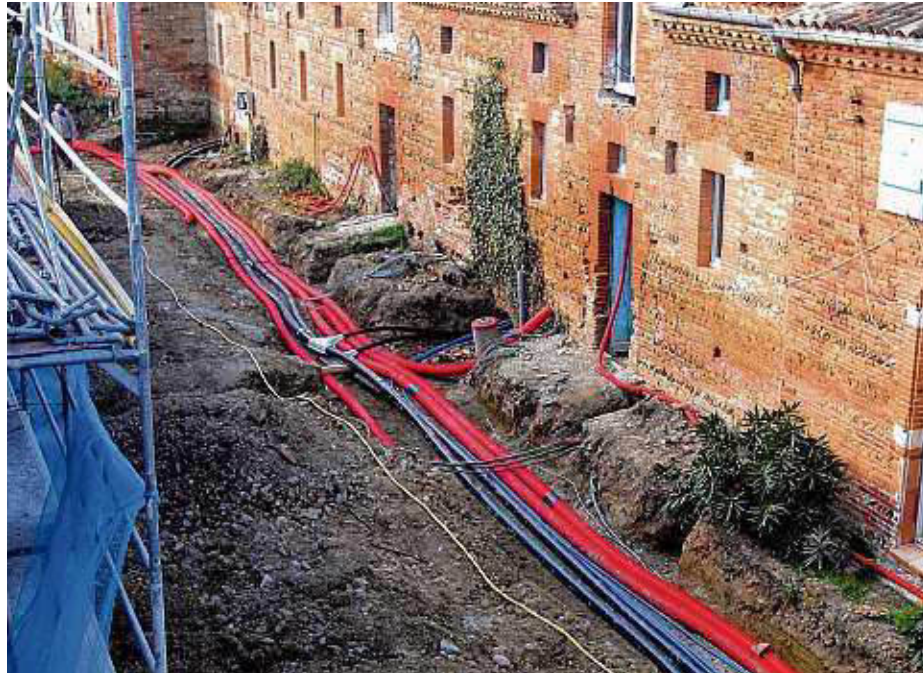
Die alten Gemäuer werden mit moderner und sehr komplexer Technik ausgestattet.
