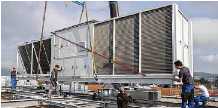
Hoch oben auf dem Hochrhein-Center wird die Wärme- und Kältezentrale installiert. Sie ist 18,6 Tonnen schwer.
