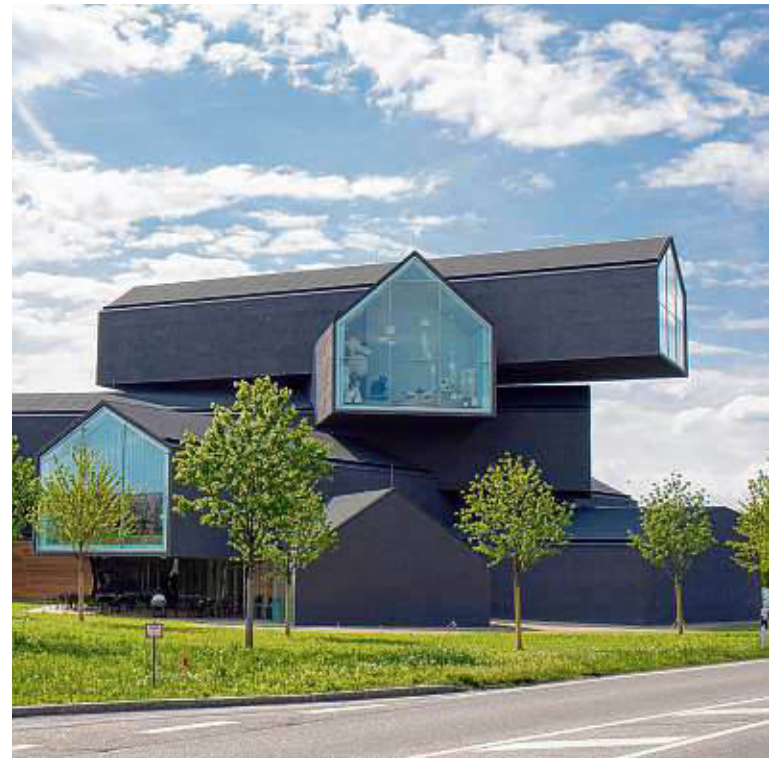
Das VitraHaus in Weil am Rhein steht für modernste Architektur. Hier installierte Tröndle Haustechnik die anspruchsvolle Haustechnik. BILD: TRÖNDLE HAUSTECHNIK
